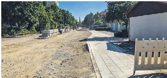
Der Ausbau der Straße Am Sulzbogen liegt im Zeitplan.
